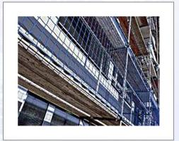
Für Seitenschutznetze und Netze in Dachfanggerüsten sind die EN 1263-1, die DIN EN 13374 sowie für die Montage die EN 1263-2 und die DGUV-I 201-023 maßgebend. Diese Netze werden als Schutznetzsystem U (Schutznetz in Tragkonstruktionen für vertikale Verwendung) bezeichnet. Bei Einsatz von Netzen kann auf den Zwischenholm verzichtet werden. Ringsum werden die Netze mit einem angekettelten Einfassseil versehen. Aus Polypropylen hochfest, ca. 5 mm, mit angeketteltem
