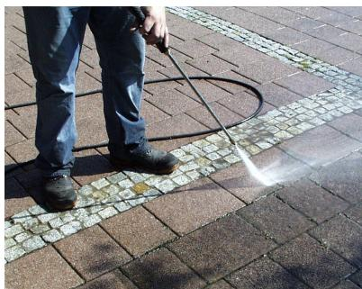
Sprühlanze SL 8: komplette Sprühlanze, Bedüsing abgestimmt auf Hochdruckpumpe, Sprühlanzenkopf mit integrierter Umschaltmöglichkeit Hochdruck/Niederdruck, inklusive Hochdruckschlauch 8 m lang. Chemical Kit CK: Die Hochdruckpumpe ist mit einer Dosiereinrichtung für chemische Zusätze ausgestattet. Mit dem CK können diese Zusätze aus Behältern angesaugt und zudosiert werden.
